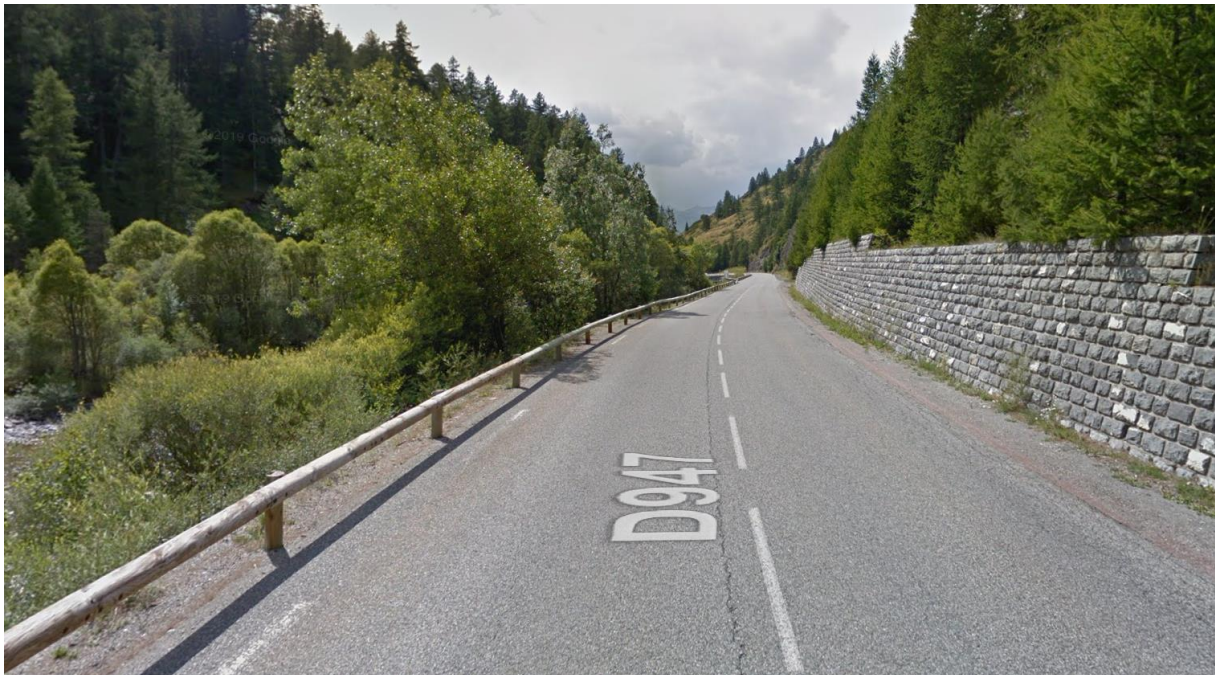
Photographie 3 : L'espace boisé classé vu depuis la route en provenance d'Abriès-Ristolas ; source : googla maps
